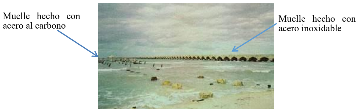
Figura1. Comparación entre el muelle hecho con acero inoxidable (derecha) y muelle hecho con acero al carbono (izquierda) (Klueh, R. L., & King, J. F. 1982).
