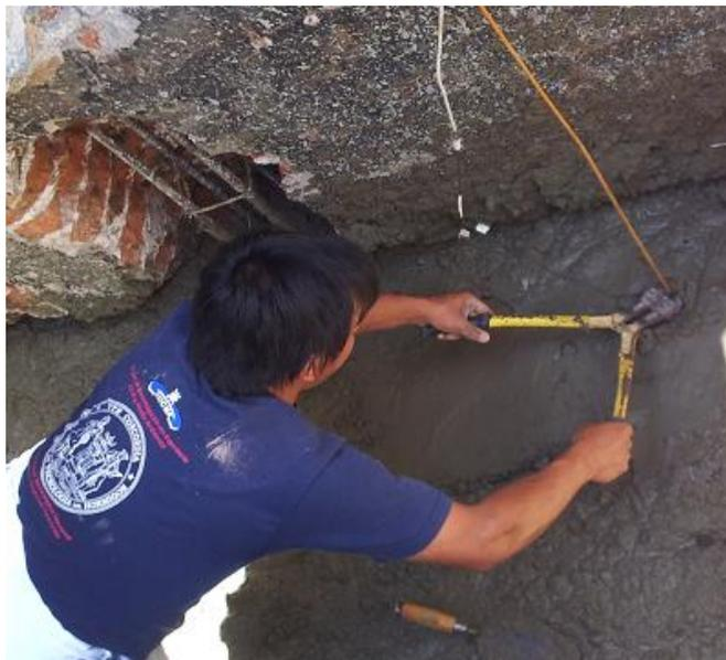
Figura 4. Colocación de sensores
