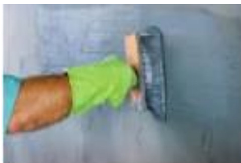
Figura 17b. Aplicação de primer como preparação de superfície
