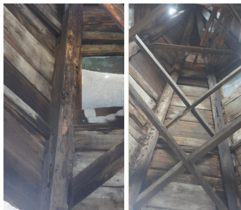
Figura 22. Detalhe da situação da coberta
