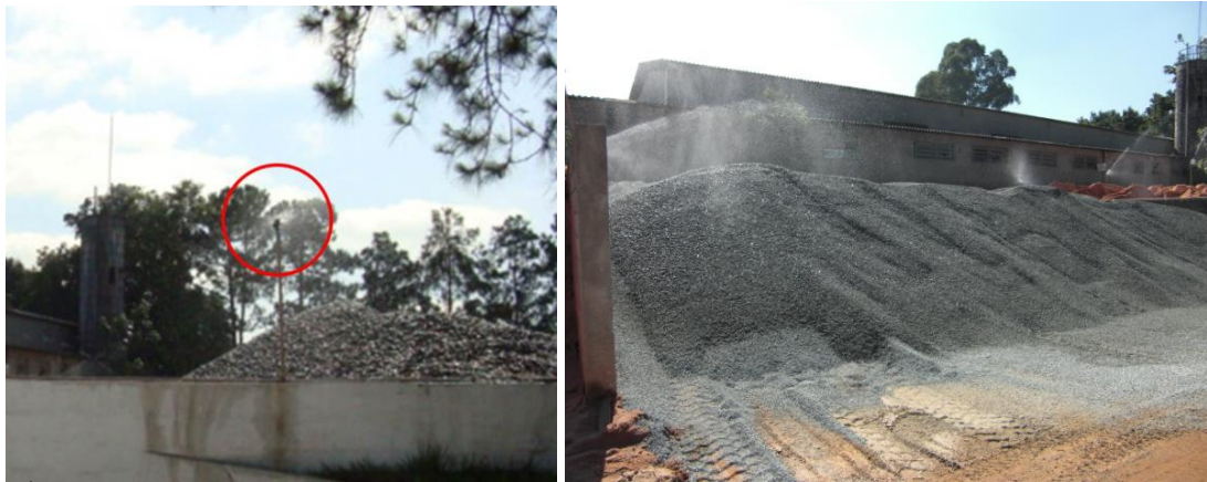
Figura 6. Árido grueso siendo rociado con agua en la planta dosificadora de la Compañía de Hormigón Premezclado
