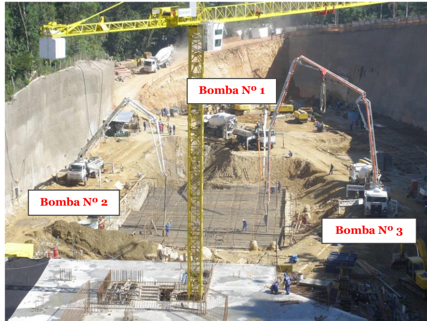
Figura 10. Vista general – bombas de hormigón ubicadas en su sitio.
