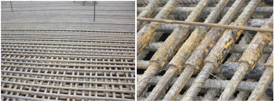
Figura 12. La armadura superior consistía en dos capas dobles de barras de 32mm. El hormigón HAC se diseñó para pasar a través de esta armadura.
