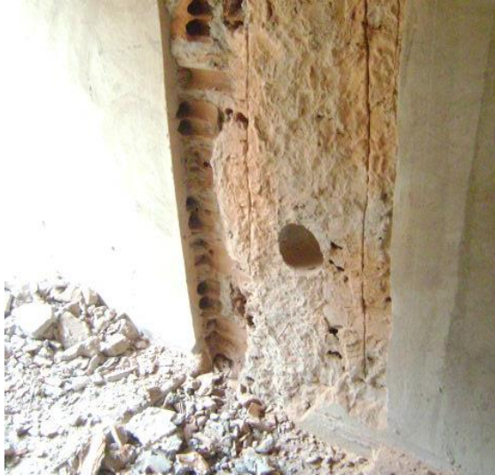
Figura 4. Local de la extracción de testigo en un pilar.
