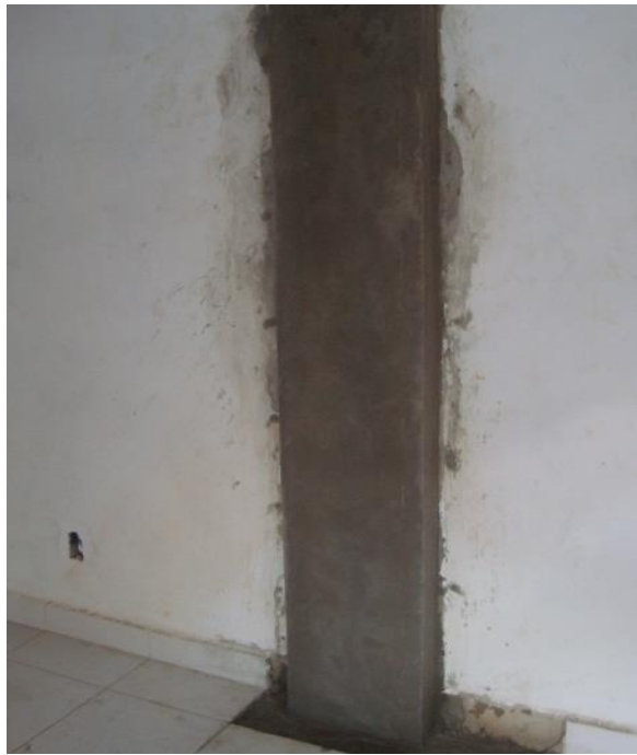
Figura 10. Aspecto final de los pilares reforzados.
