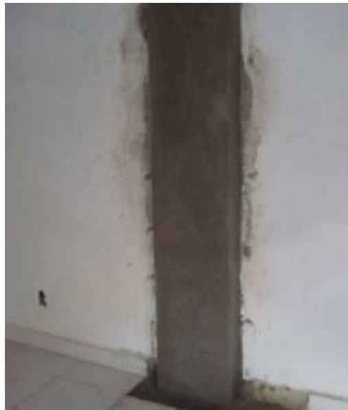
Figura 10. Aspecto final dos pilares reforçados.
