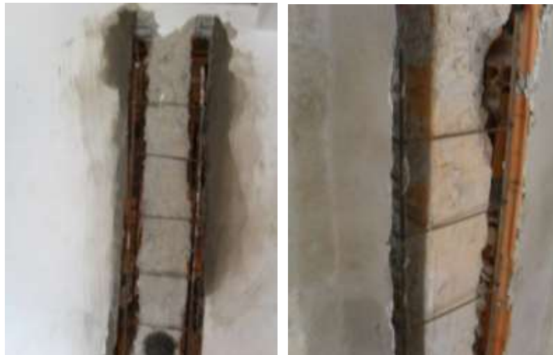
Figura 8. Armaduras longitudinais e estribos do reforço dos pilares.
