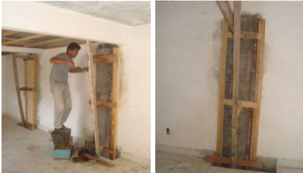
Figura 9. Concretagem do reforço dos pilares.
