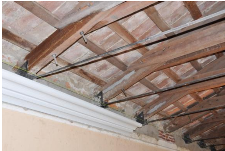
Figura 13. Reparación de fisuras paralelas
