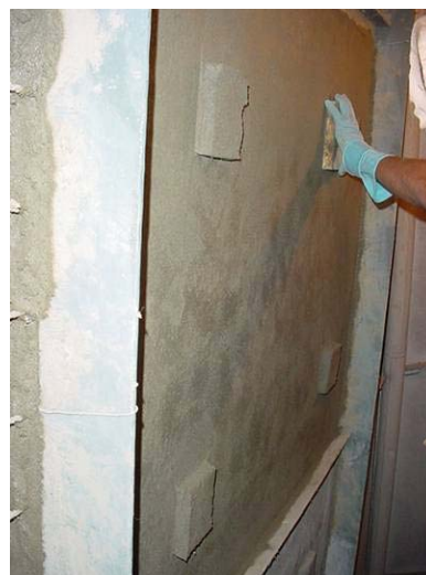
Figura 6. Tela com revestimento de argamassa. (Fonte: Arquivo da Equipe do Projeto de restauro do MNBA)
