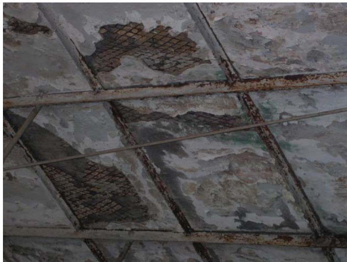
Figura 4. Aspecto da argamassa interna da cúpula Norte.
