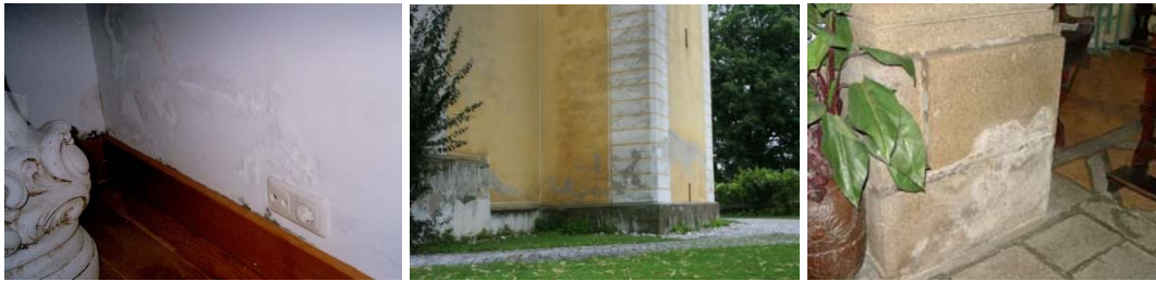
Figura 1. Humidade Ascensional.
