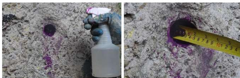
Figura 4: Parede do poço úmido com o concreto alcalino.
