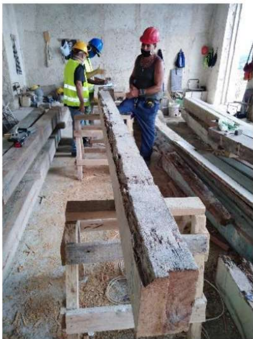
Figura 3. Etapa de inspeção detalhada em viga montada em burros de madeira
