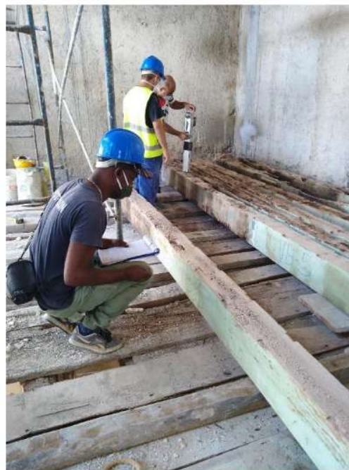
Figura 4. Inspeção e classificação visual de vigas desmontadas
