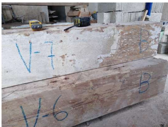
Figura 8. Identificação de vigas de madeira
