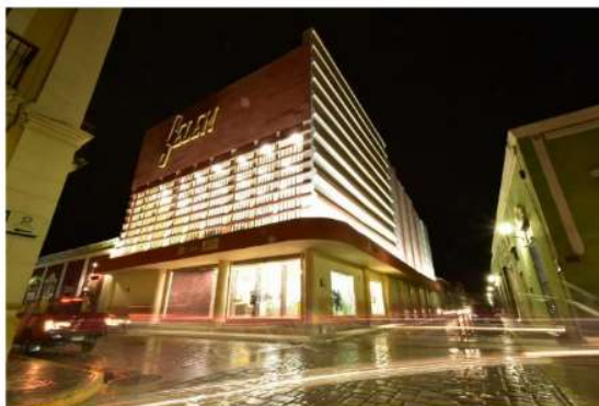
Figura 7. Vista noturna do edifício após intervenção
