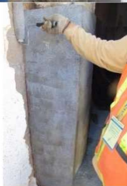
Figura. 6. Processo de reparo profundo uniforme
