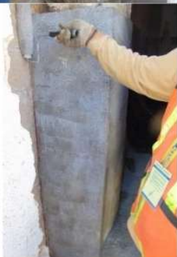
Figura. 6. Proceso de reparación profunda uniforme
