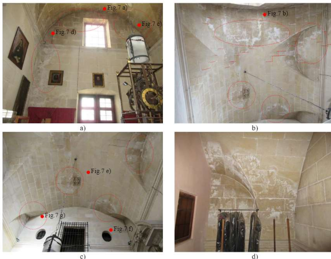
Figura 2. Fotos de salas bajo cubierta 2: a) Fachada Este, b) Vista inferior de la cubierta, c) Vista inferior de cubierta con tabique divisorio de bóveda, d) Sala anexa superior tras división con tabique. Fotos de salas bajo cubierta 1: e) Vista inferior de la cubierta zona próxima a fachada exterior, f) Vista inferior de la cubierta en contacto con el cuerpo de la iglesia. Figuras a), b), c) y d) incluyen los puntos de tomografía de la Figura 7 con puntos rojos.
