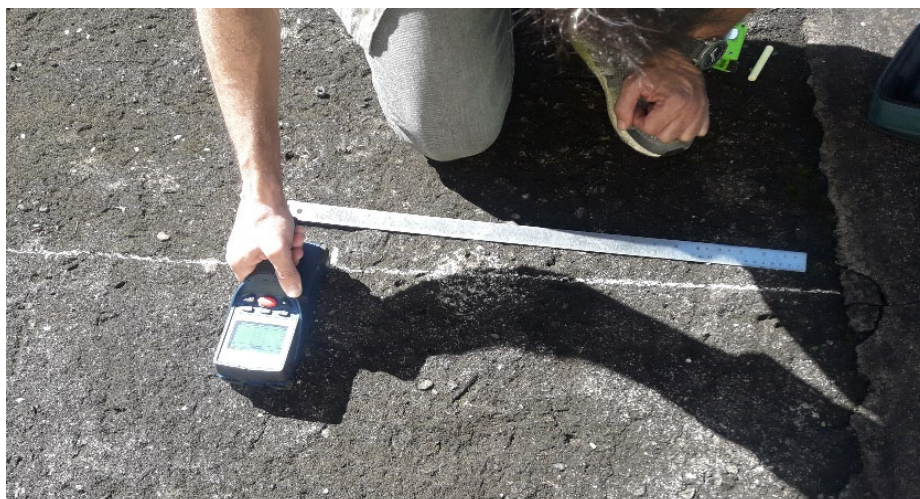
Figura 9. Ejecución de la prueba de pacometría
