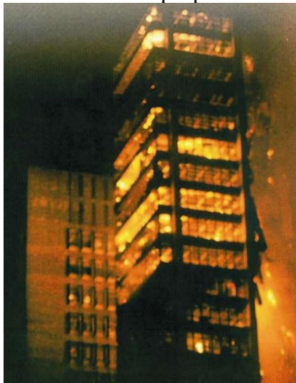
Figura 16. Parte frontal remanescente do edifício Sede II
