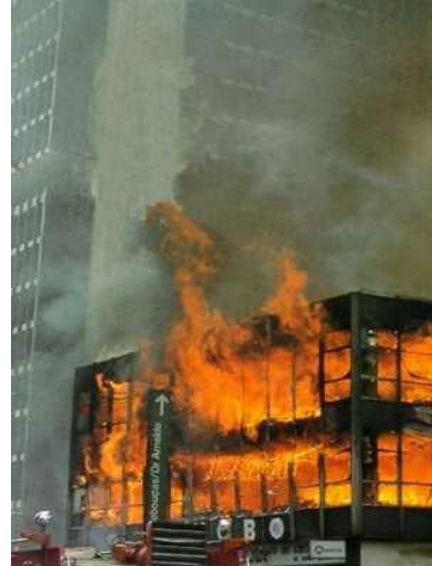
Figura 2. Pódio do edifício Grande Avenida, submetido a incêndio em 14/02/1981
