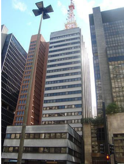
Figura 1. Edifício Grande Avenida, destacando pódio frontal associado à torre com 22 pavimentos
