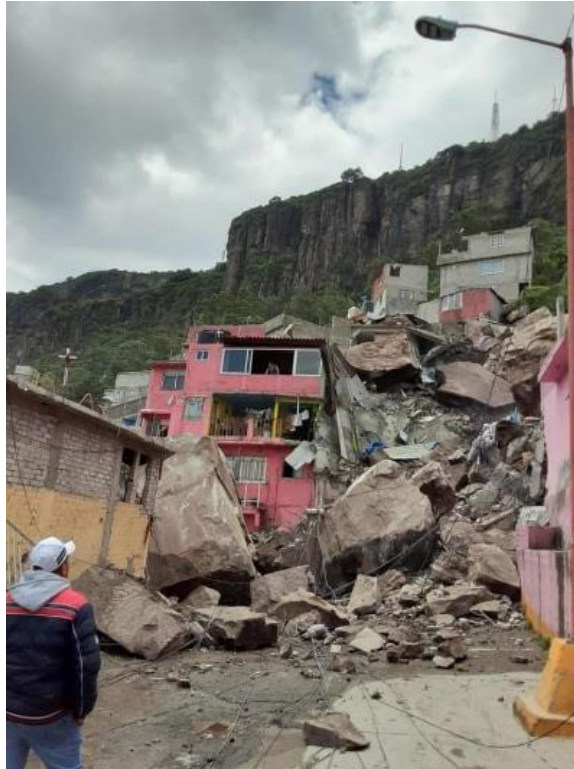
Fotografía 2. Deslizamiento de tierra en Cerro del Chiquihuite, alcaldía Gustavo A. Madero
