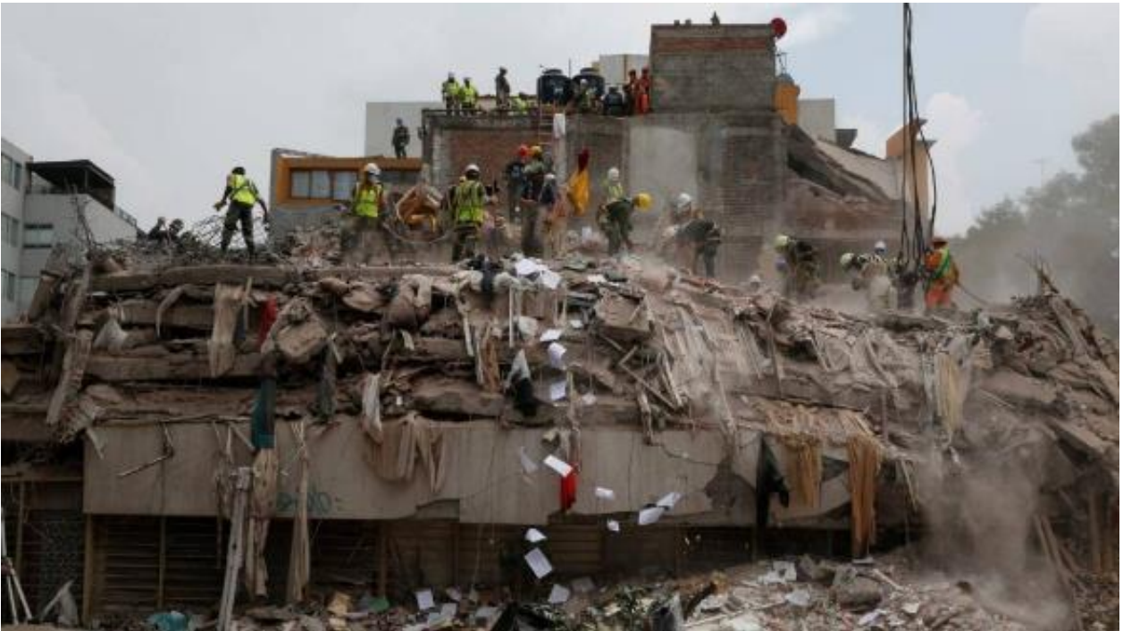
Fotografía 3. Consecuencias del sismo del 19 de septiembre de 2017
