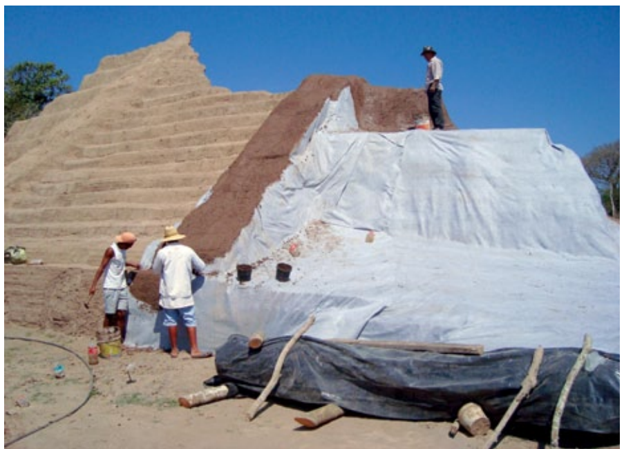
FIGURA 7. Colocación del geotextil sobre la fachada de la pirámide (Fotografía: Luis Guerrero, 2009).
