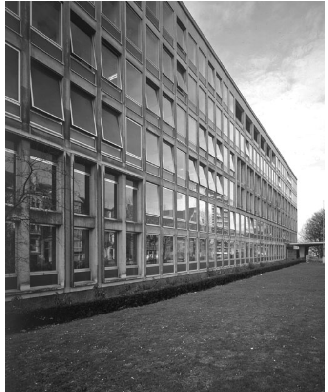
FIGURA 2. Fachada frontal del IRPA (Fotografía cortesía: ©KIK-IRPA, Bruselas, 2012, Folio G3277).
