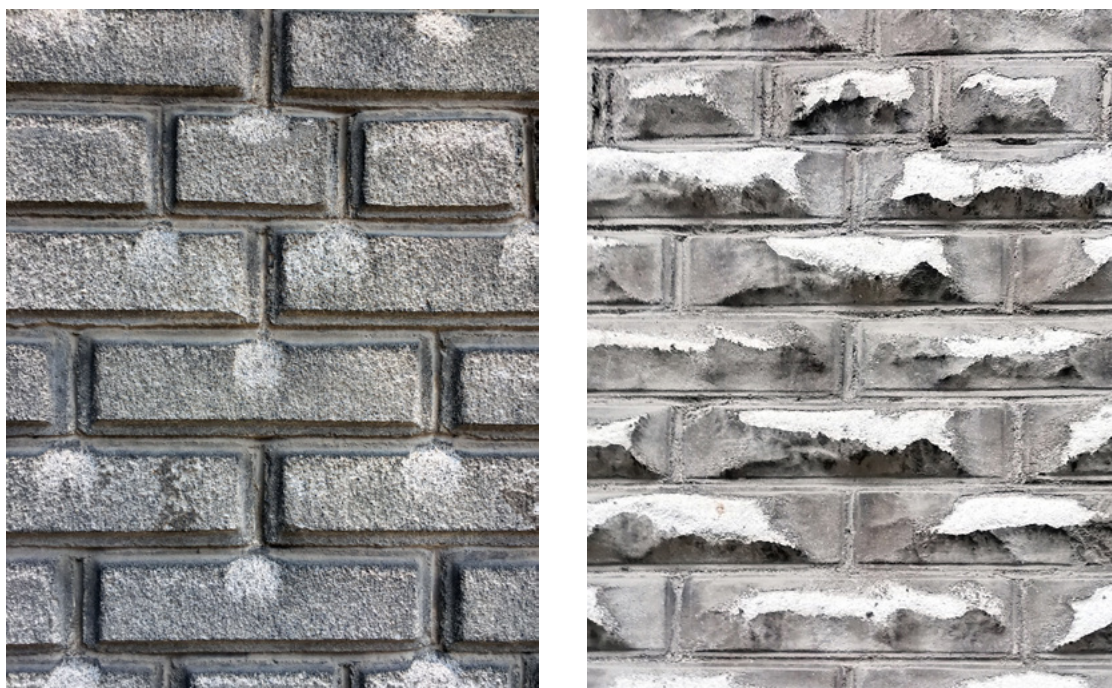
FIGURA 2. Dos tipos de tabique de cemento (20 x 10 x 6 cm). Izquierda, detalle del aparejo del tabique liso con bisel; derecha, detalle del aparejo de tabique grotesco con bisel (Fotografías: Alejandro Leal y Alberto Muciño, 2020; fuente: colección de los autores).
