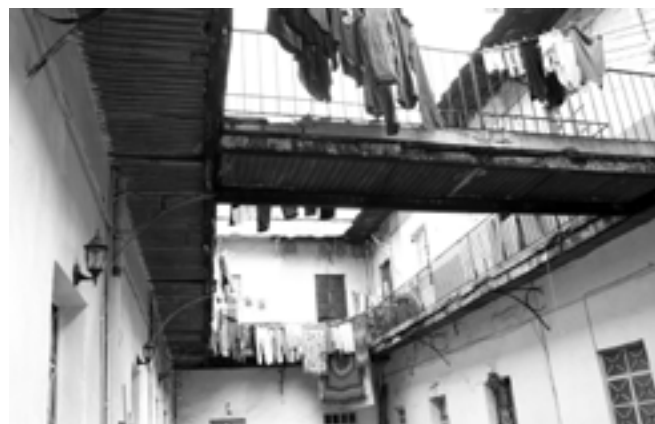
FIGURA 6. Sistema de andadores de vigueta y lámina de metal al interior de República de Cuba núm. 32 (Fotografía: Patricia Sánchez, 2017).
