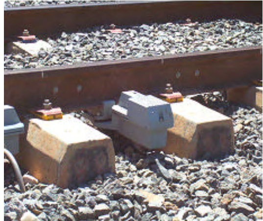
Figura 3. Detector de ejes calientes
