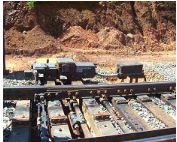
Figura 4. Aparato de cambio para vía de escape
