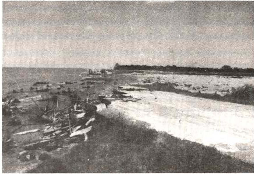
Foto 1. Vista del tramo poniente de la carretera destruida que iba de Ciudad Frontera a Ciudad del Carmen. (Foto de O. Manzano, 1987.)
