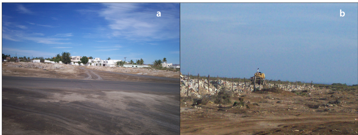
Figura 7. Áreas en la planicie costera, rellenadas con escombros para elevar el nivel del suelo. Su ubicación (7a y 7b) se muestra en las Figuras 2 y 6 (elaboración propia).
