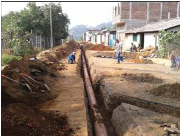
Figura 2. Construcción de drenaje.
