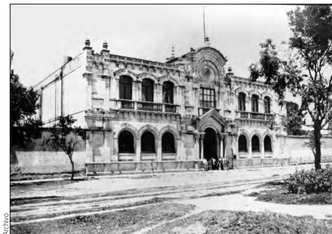
Fachada del antiguo Hospital M. Silva (1903), Morelia.
