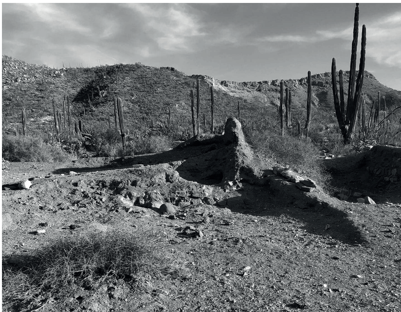
Figura 1. Restos de muros de adobe de la capilla de San Francisco Regis. Fotografía de Juan Manuel Guillén
