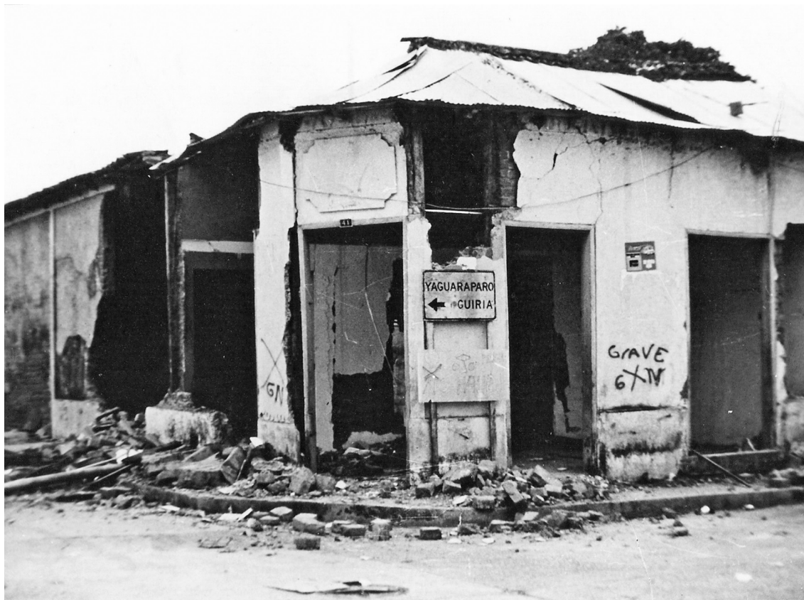
Daños en vivienda de bahareque en la localidad de El Pilar, al oriente de Venezuela, por el sismo del 11 de junio de 1986.
