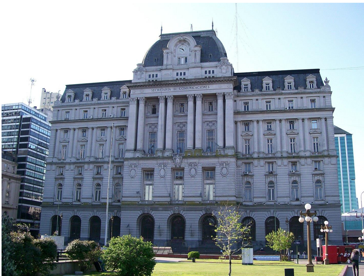
Figura 3. Palacio de Correos y Telecomunicaciones. Ciudad de Buenos Aires, Argentina
