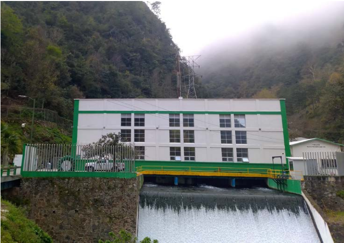
Figura 1 Mini hidroeléctrica en las Minas, Veracruz, México
