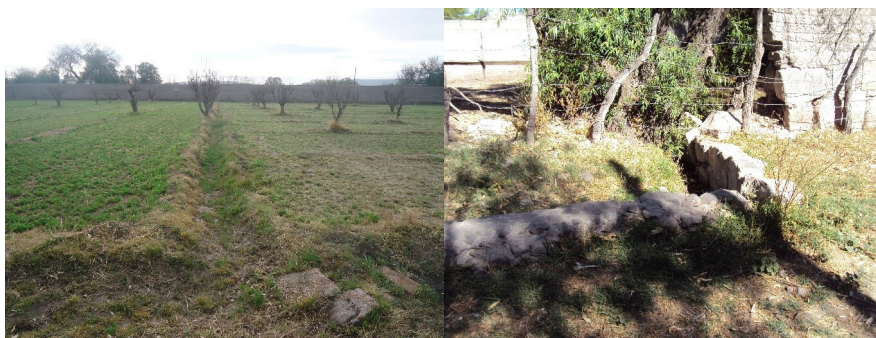
Fotos 5 y 6. Izquierda acequia tipo zanja; derecha acequia con perfiles de piedra.
