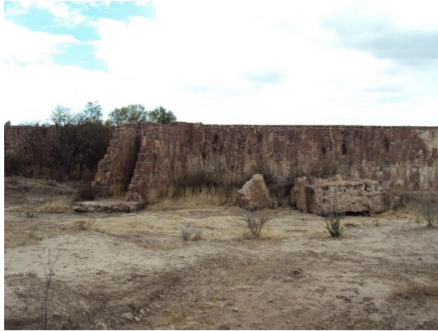
Foto 4. Parte de la cortina de la presa de Santa Rosa, en ella se puede observar una de sus compuertas. Fuente: FAMB, 28 de junio de 2013.
