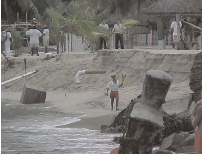
Figura 3. Fotografía donde se observa la erosión y el escarpe de la playa después del evento erosivo. Figure 3. Photograph showing the erosion and beach scarp after the event.
