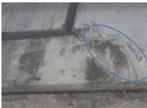
Fig. 8: Cabezal con grietas e inicio de corrosión en el concreto (Honorato, 2014).
