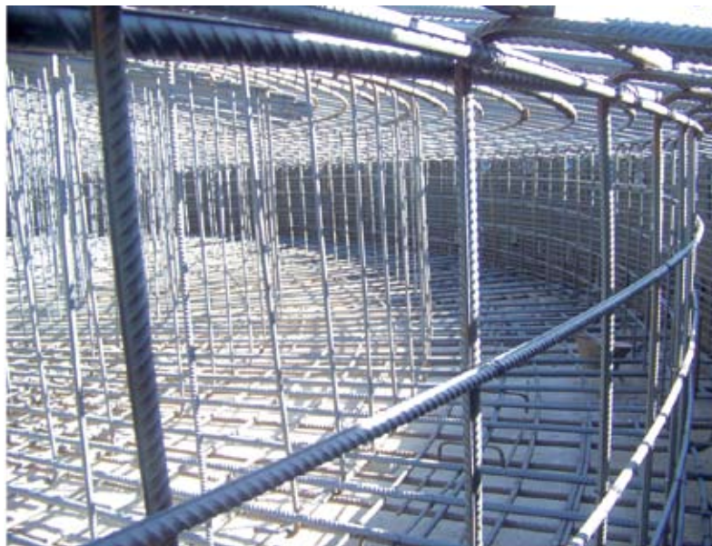
Fig. 17: Armado circunferencial de una base tronco-cónica.
