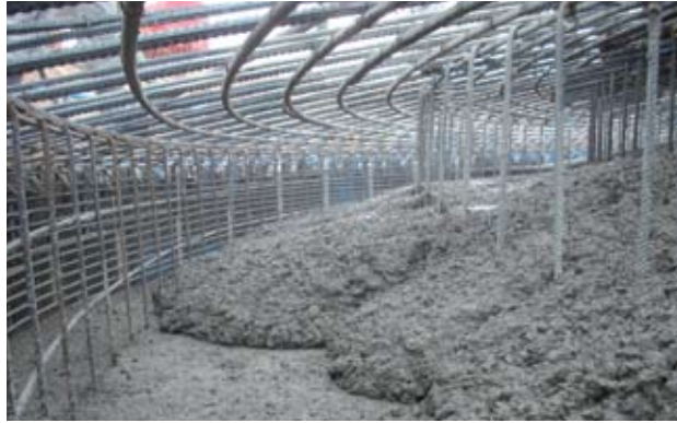
Fig. 18: Proceso de hormigonado de una base para aerogenerador.
