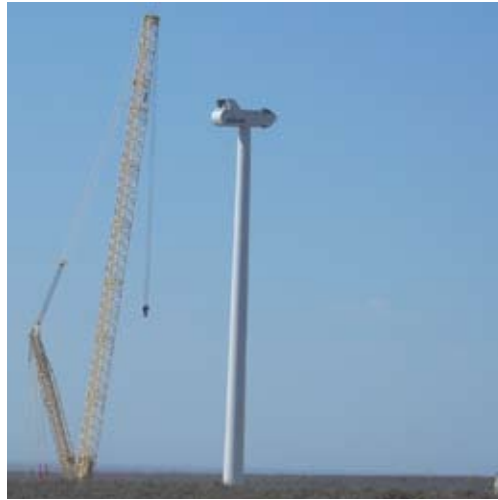
Fig. 1: Aerogenerador de 90 m de altura en etapa de montaje.
