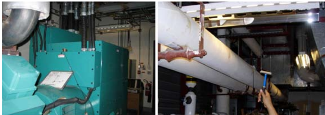
Figura 2: Configuración de pruebas de vibración en operación y forzadas para distintos CNEs.
