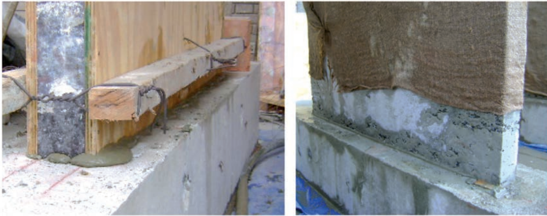
Fig. 11: Fuga de lechada de cemento en la base del muro, por falta de hermeticidad del encofrado, y pequeñas cangrejas con segregación de agregados.
