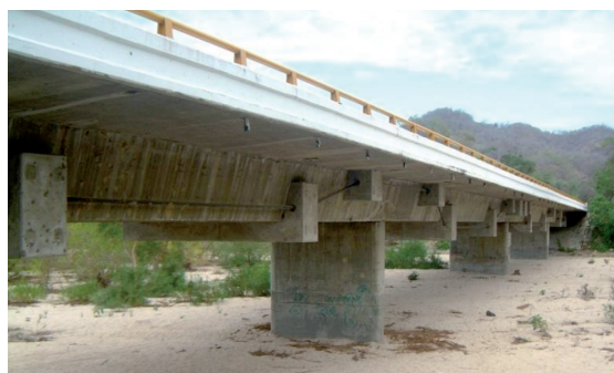
Fig. 1: Puente Motín de Oro. Foto tomada por Jara et al. , 2009.
