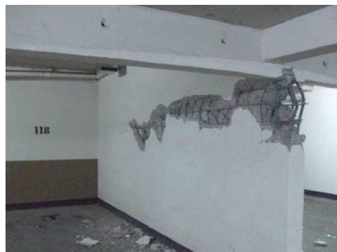
Fig. 5. Efecto de muros transversales. Edificio Sol Oriente, Santiago. Nótese que la falla se concentra principalmente en el borde libre.
