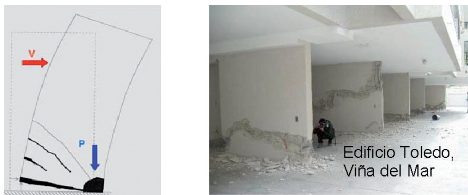
Fig. 3. Falla por flexión.
