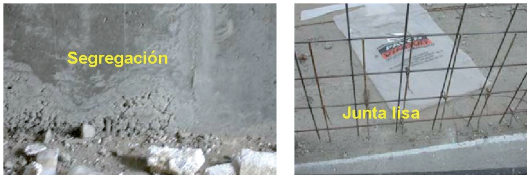
Fig. 10. Algunas de las causas de la falla por deslizamiento.
