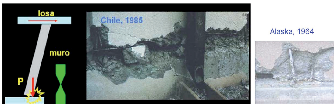
Fig. 11. Consecuencias de la falla por deslizamiento.
