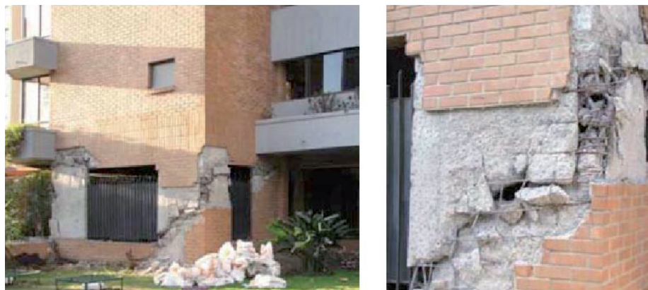
Fig. 8. Falla por corte en un edificio en Viña del Mar, con trituración de los extremos y pandeo del refuerzo vertical no confinado.
