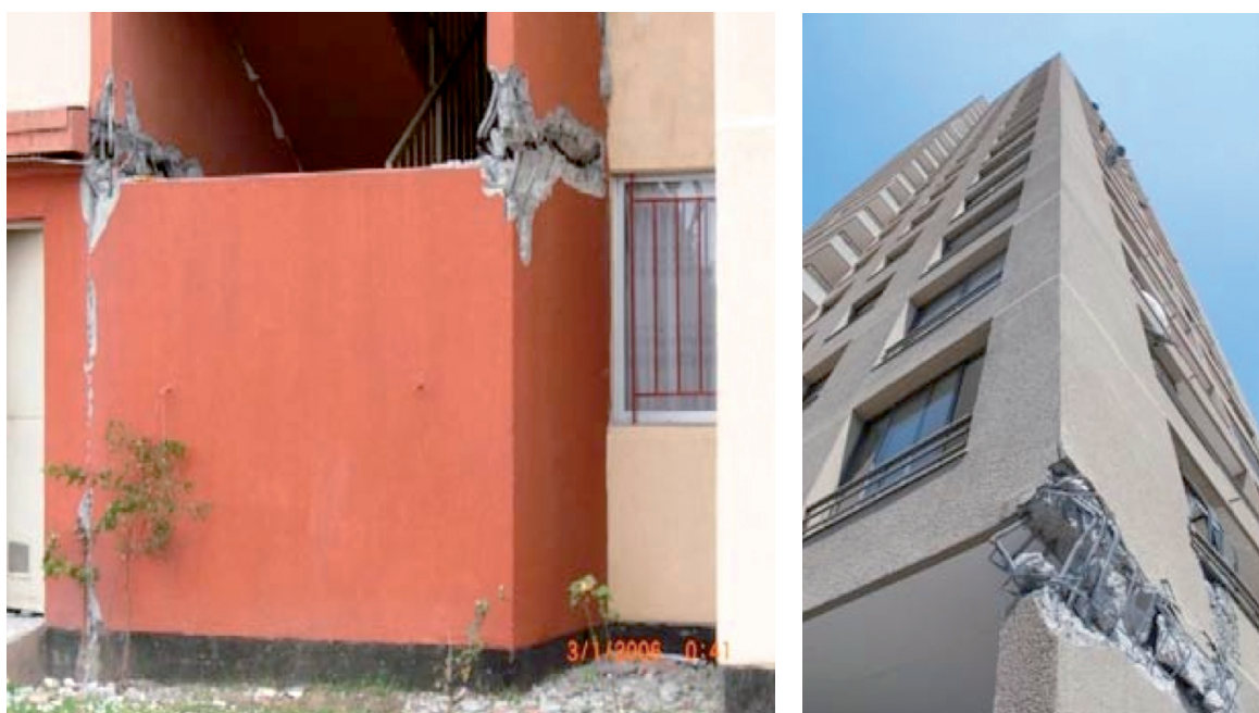
Fig. 4. Ausencia de confinamientos en los extremos del muro.
