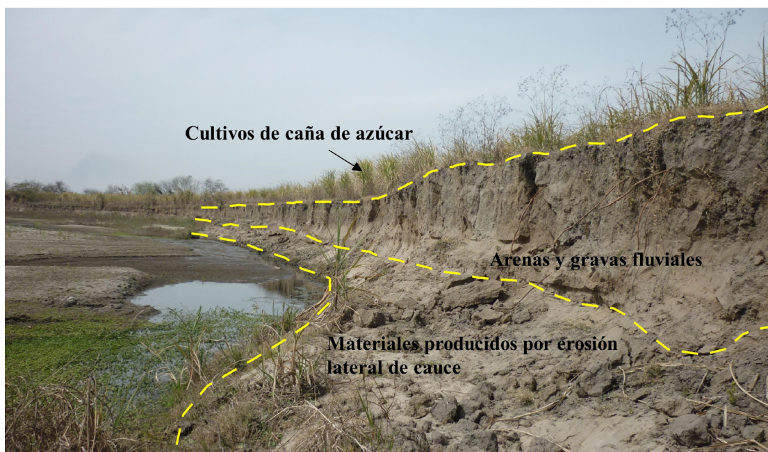
Figura 4 Barrancas de la margen derecha del río Seco, compuestas de arenas y gravas fluviales. Curva de meandro (27°17'56.17"S; 65°31'38.65"O). Pueden observarse los cultivos de caña de azúcar.
