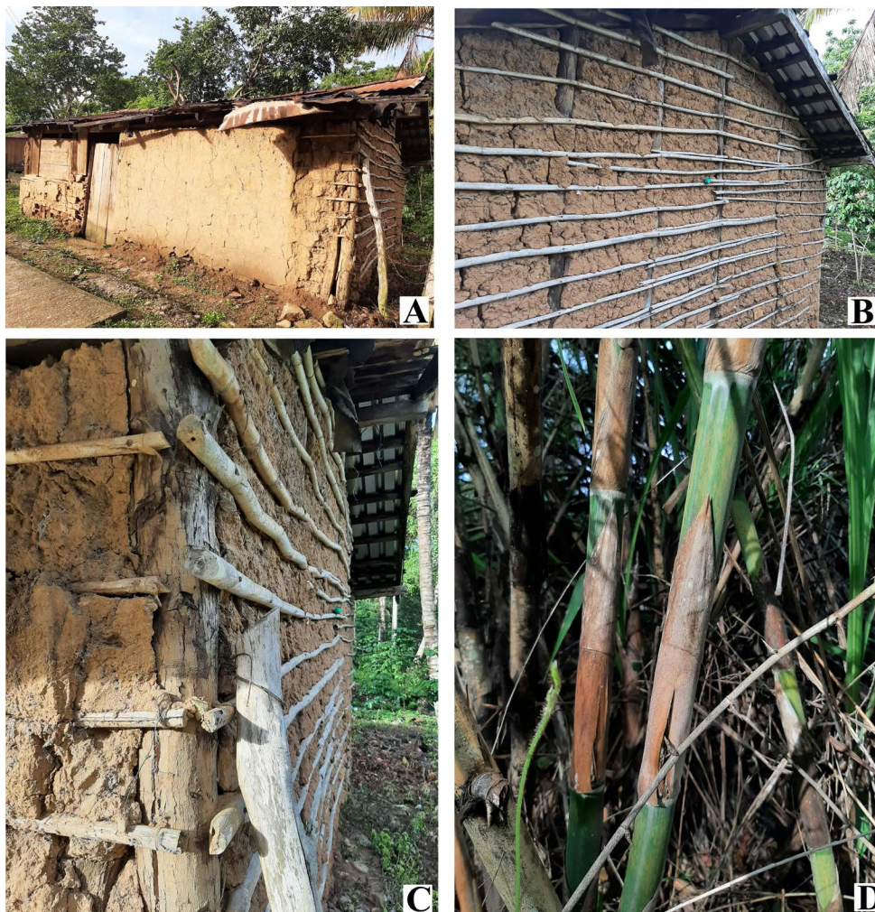
Figura 6. Casa habitación de bajareque construida con Guadua paniculata en Río Santiago, Atoyac de Álvarez, Guerrero. A. Fachada con repelle. B. Muro lateral donde se observan los culmos de G. paniculata . C. Acercamiento de la esquina con detalle de los culmos de G. paniculata . D. Culmos de G. paniculata . Fotografías de Eduardo Ruiz-Sanchez.
