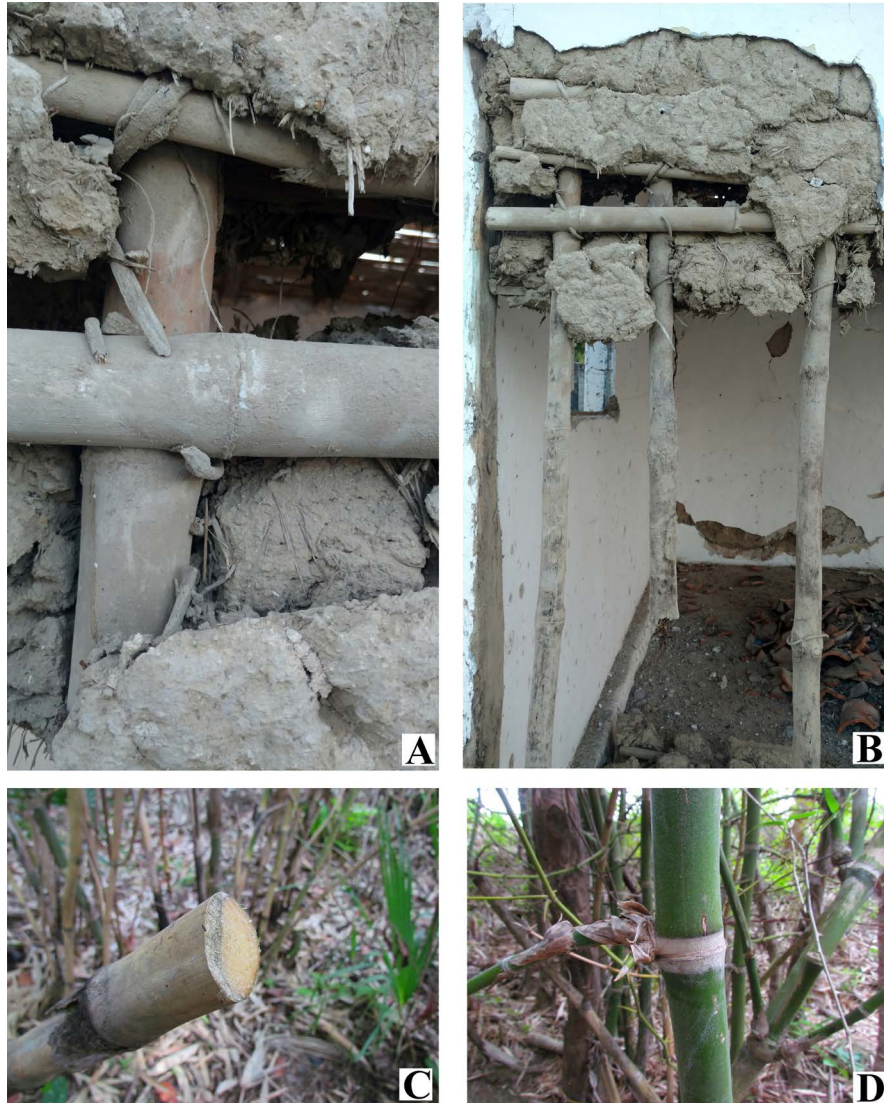
Figura 7. A. Detalle del muro de bajareque construido con Guadua amplexifolia en Santo Domingo Zanatepec, Oaxaca. B. Muro de bajareque donde se observan los culmos de G. amplexifolia . C-D. Culmos de G. amplexifolia . Fotografías de Eduardo Ruiz-Sanchez.
