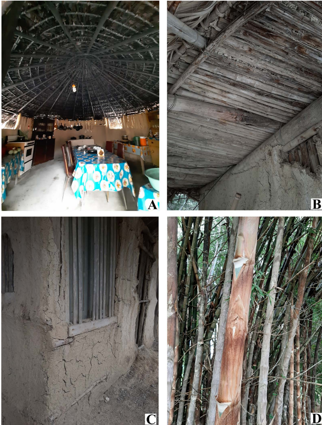
Figura 8. A. Techo construido con Guadua velutina , región Huasteca Potosina, San Luis Potosí. B. Muro de bajareque y techo de G. velutina . C. Esquina de casa habitación construida con G. velutina . D. Culmos de G. velutina . Fotografías de Eduardo Ruiz-Sanchez.
