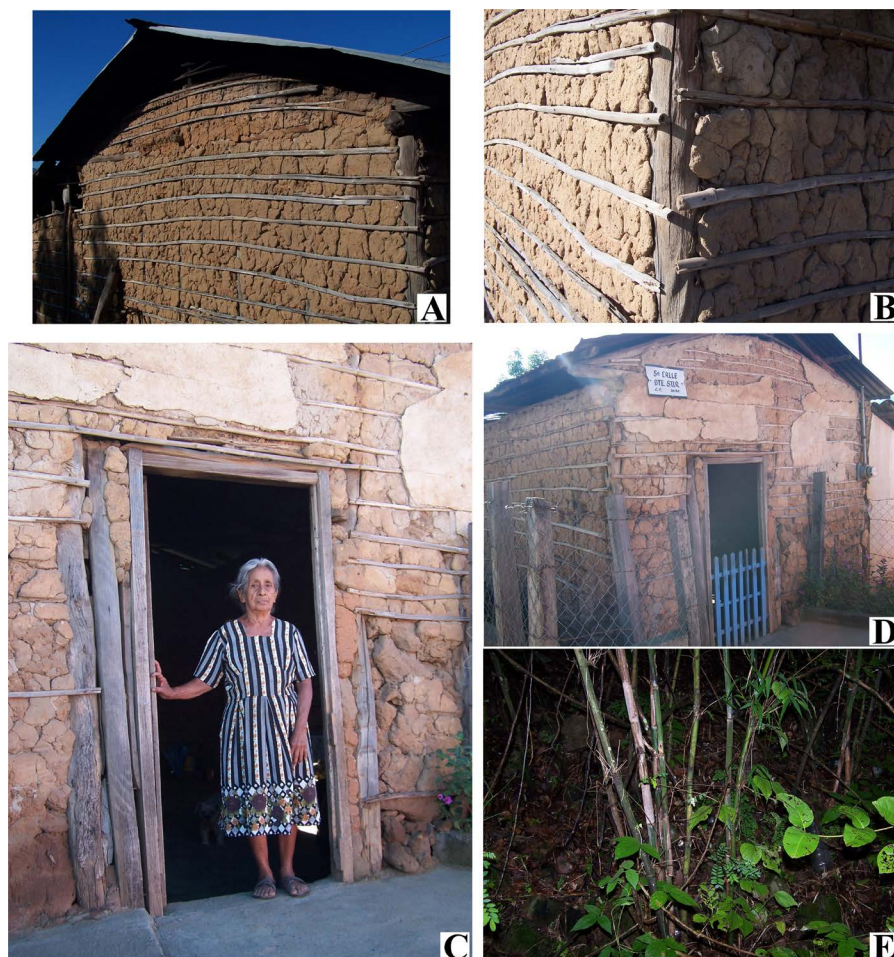
Figura 3. Casa habitación de bajareque construida con Guadua paniculata en Frontera Comalapa, Chiapas. A. Contrafachada. B. Esquina donde se observa el bajareque con los culmos clavados a la viga de madera. C-D. Fachada con repelle. E. Culmos de G. paniculata . Fotografías de Eduardo Ruiz-Sanchez.
