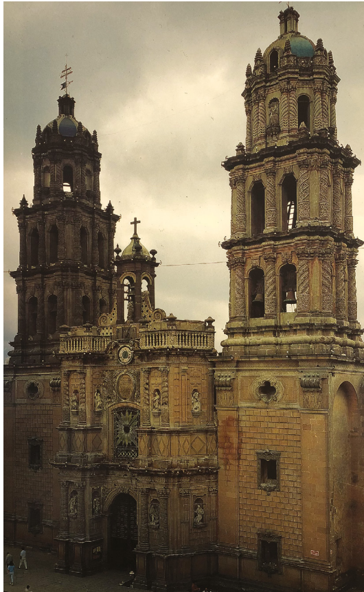
2. Catedral de San Luis Potosí. Nótese la diferencia de tonalidades de la piedra usada entre la primera torre (derecha) y la que se construyó a principios del siglo xx (izquierda). Secretaría de Cultura-INAH-MÉX. “Reproducción autorizada por el Instituto Nacional de Antropología e Historia”.
