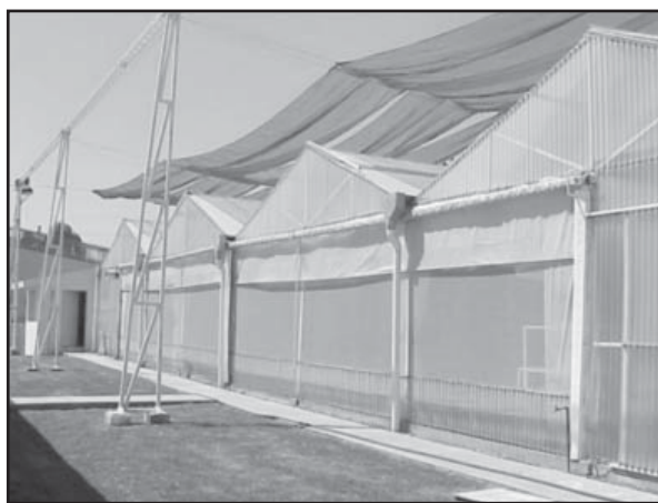
Figura 1. Invernadero experimental diseñado y construido en la Universidad Autónoma de Querétaro.
